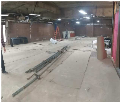
Obras no térreo do Anexo II
