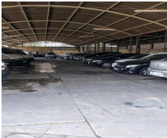
Patío coberto onde ficam estacionadas as viaturas
