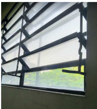
Janela com tela na fachada frontal
