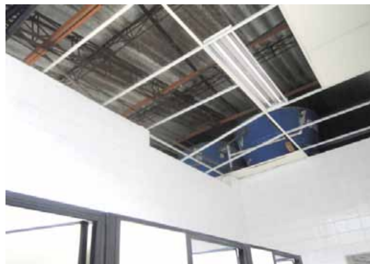
Banheiros em condições precárias de uso
