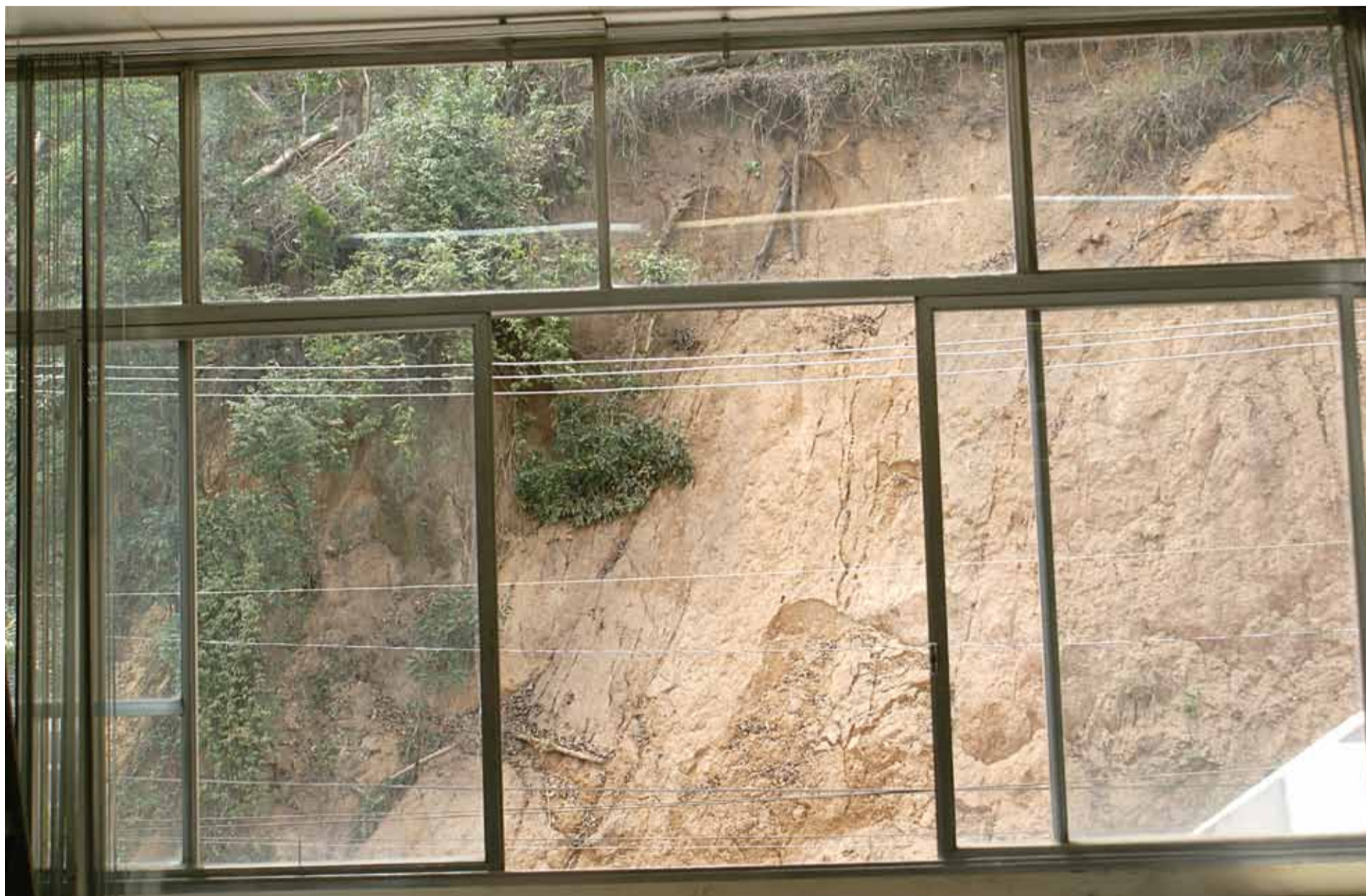
Morro em frente a Subseção de Nova Friburgo ainda ameaça deslizar
